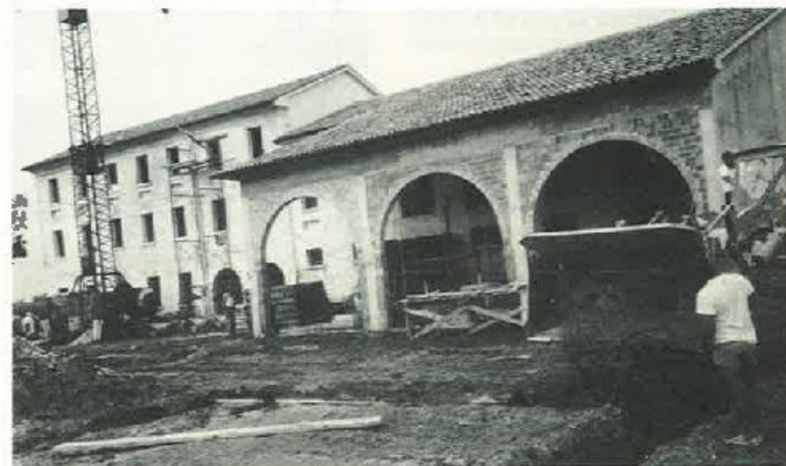
Vengono gettate le fondamenta per la costruzione del "barco".
